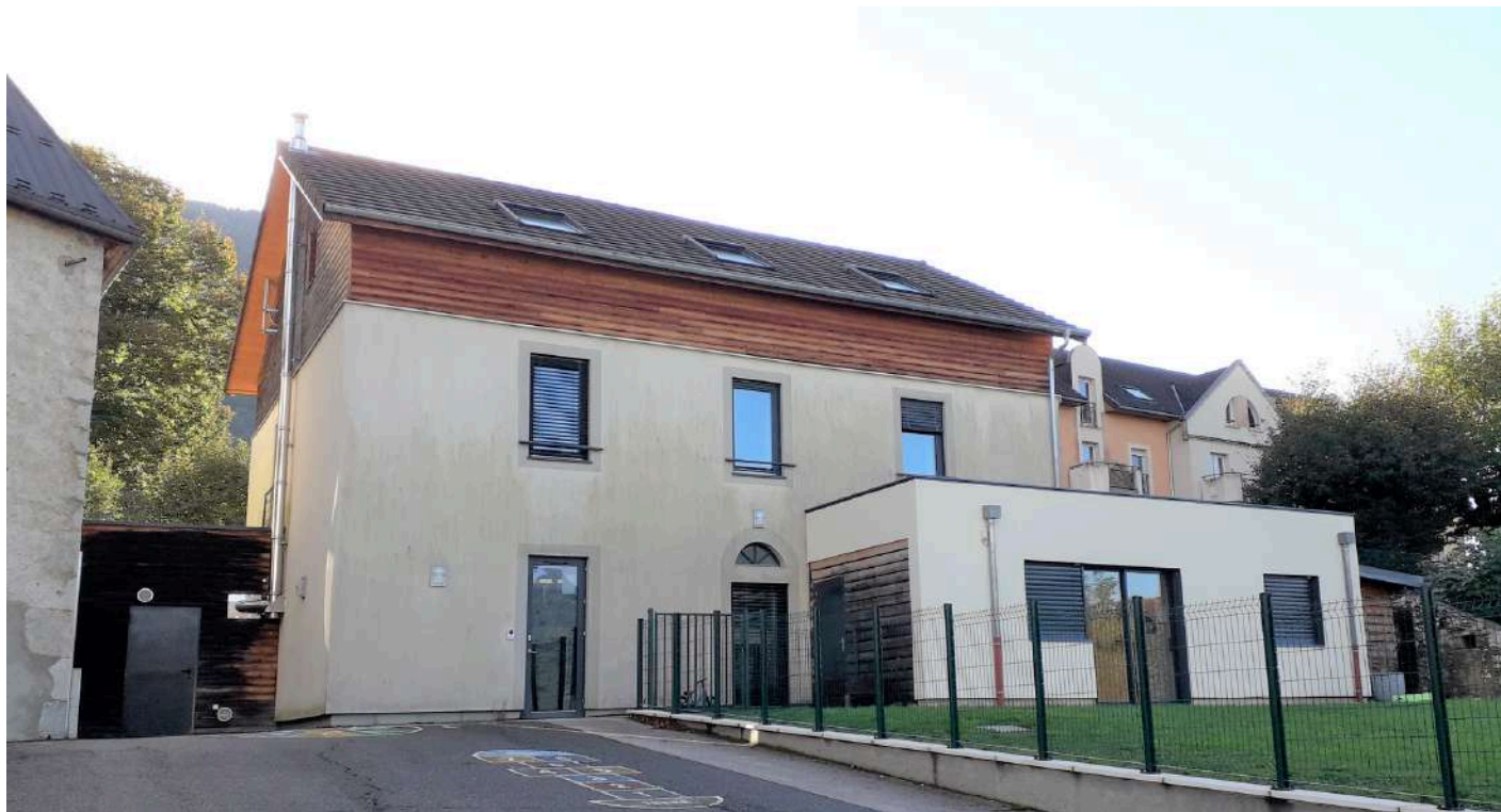
La façade principale où se lit la surélévation, l'isolation par l'extérieur et l'ajout de l'extension contemporaine
