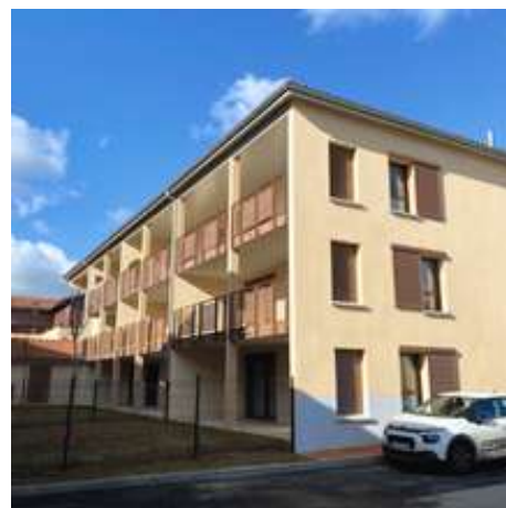
Des loggias et balcons s'ouvrent sur le jardin ou sur la cour centrale
