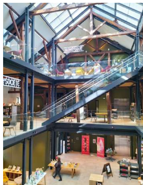
Le puits de lumière et la double charpente de la médiathèque
