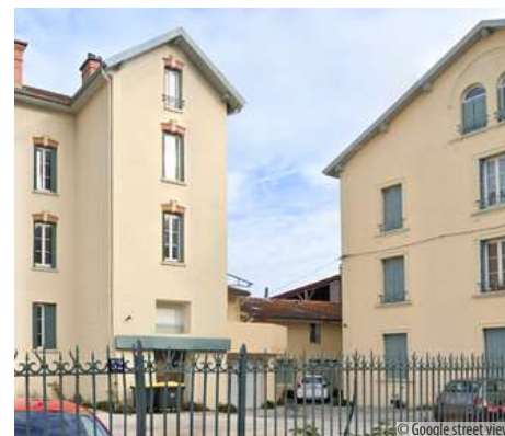
L'accès sur rue des logements, en fond de cour
