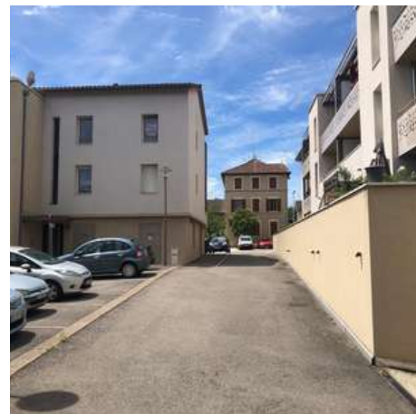
L'accès au cœur d'îlot, dans la profondeur de la parcelle
