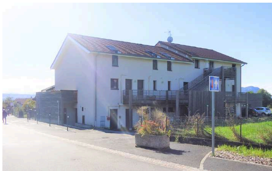
La façade arrière avec l'accès aux logements et les aménagements publics sécurisés aux abords du centre de loisirs
