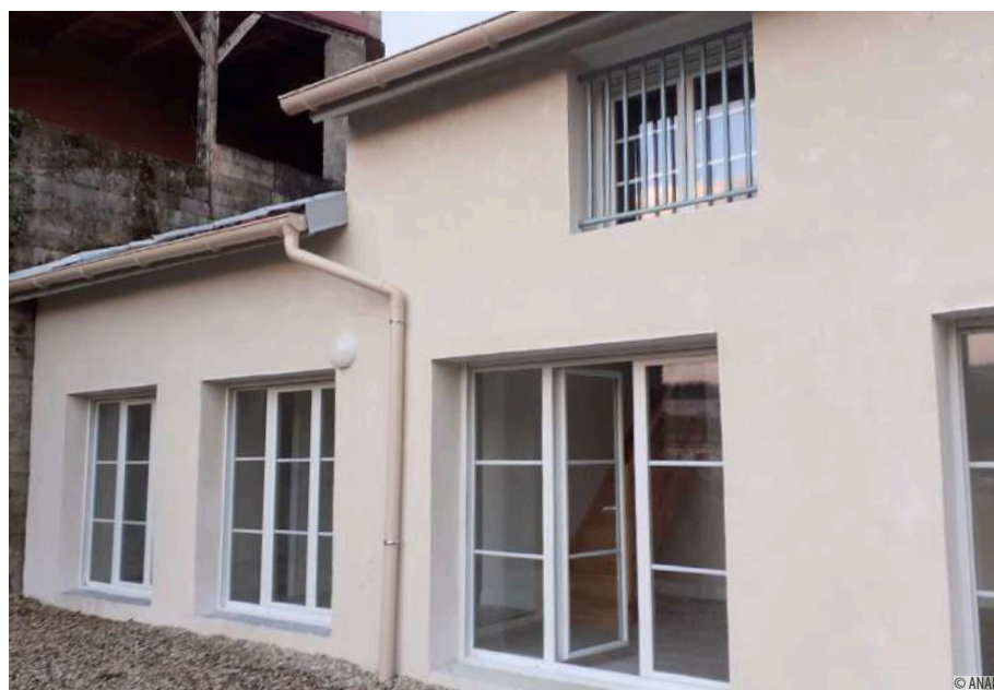
Façade arrière, les 2 appartements T3 donnent sur des espaces extérieurs privatifs généreux
