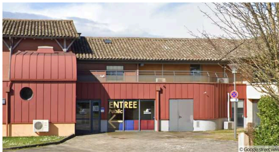
L'extension à l'arrière de la ferme devient la nouvelle façade principale d'accès
