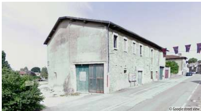
L'ancienne grange en pierre a été démolie, mais les pierres ont servies comme réemploi
