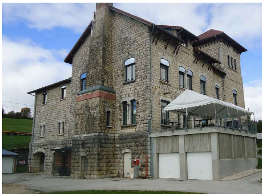
La toiture terrasse de l'extension technique a été aménagée pour l'accueil de la clientèle de la brasserie
