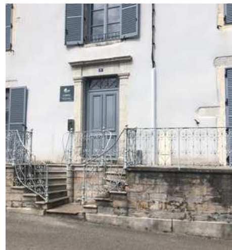
Les ferronneries restaurées
