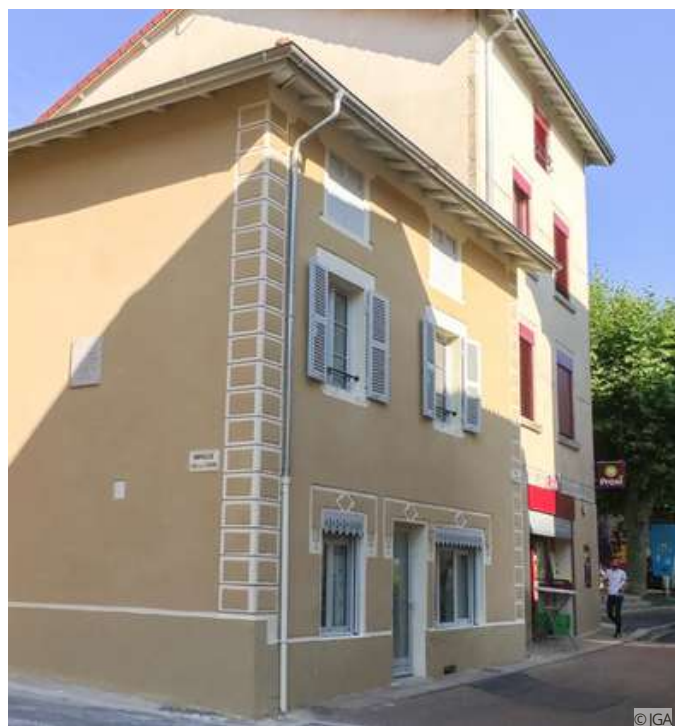
Détails des modénatures d'enduits recréés à l'identique
