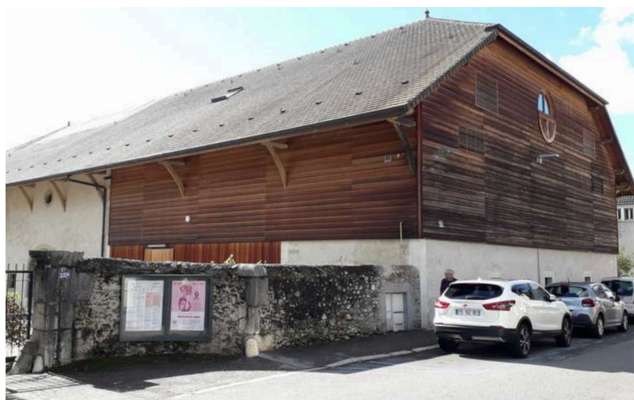
Les trois premières travées réhabilitées en théâtre
