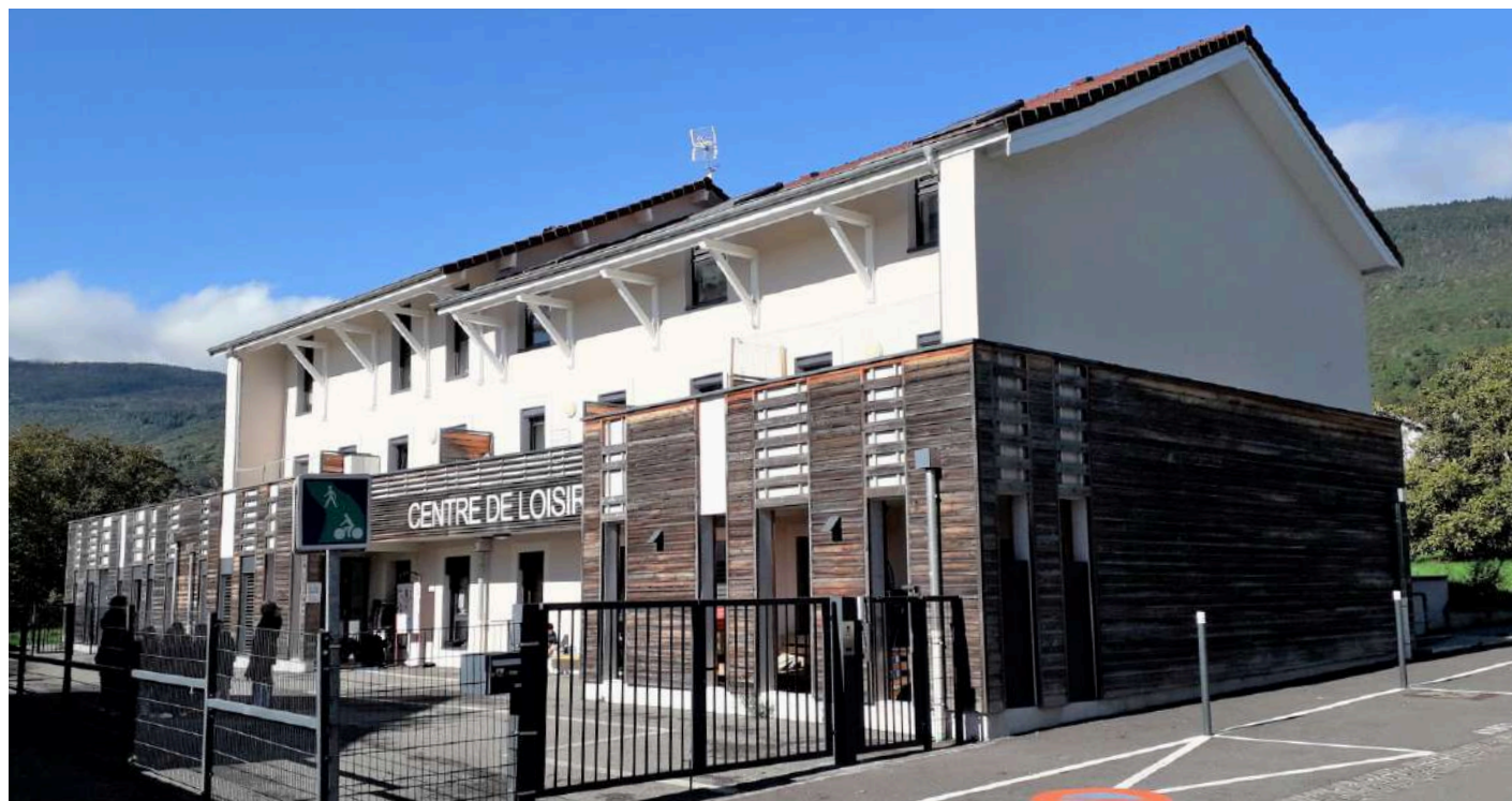
L'ancienne école-mairie s'est adaptée aux besoins des familles et à de nouveaux usages, réemployant le bâtiment d'origine
