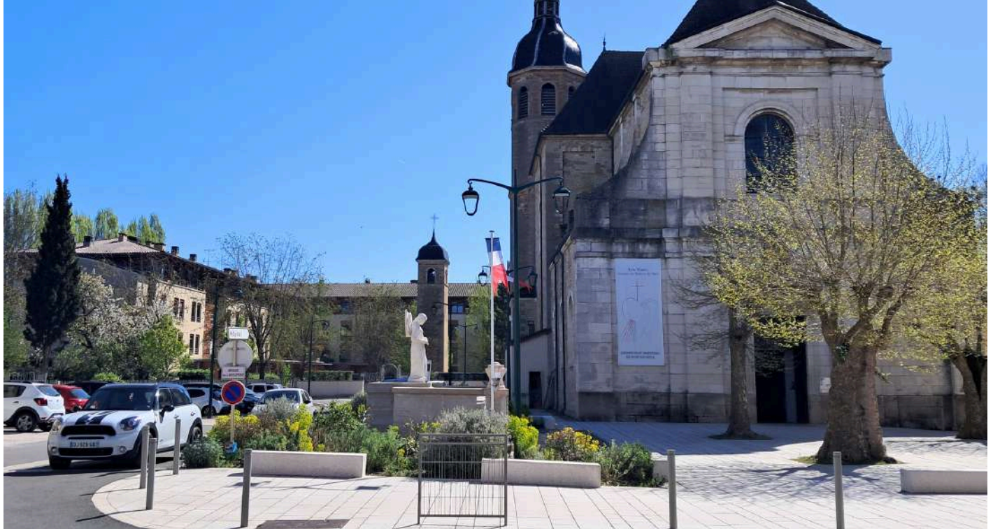
La démolition de l'ancienne fabrique de biscuit a permis d'ouvrir la perspective vers l'hôpital et de mettre en valeur l'église classée monument historique sur une place réaménagée
