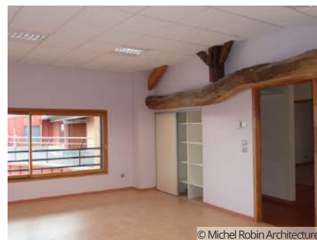
La charpente a été conservée et laissée apparente
