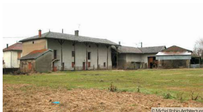
Le corps de ferme traditionnel en pisé avec ses avancées de toits et ses multiples dépendances
