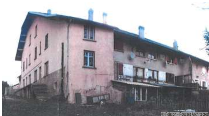
Le bâti d'origine était composé d'un corps central en retrait côté jardin et de deux ailes
