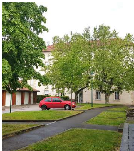
L'ambiance arborée du cœur d'îlot, traversé par la sente piétonne, a été préservée
