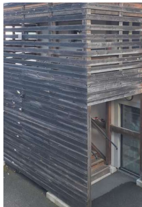
Le nouvel escalier d'accès aux logements, en bois local
