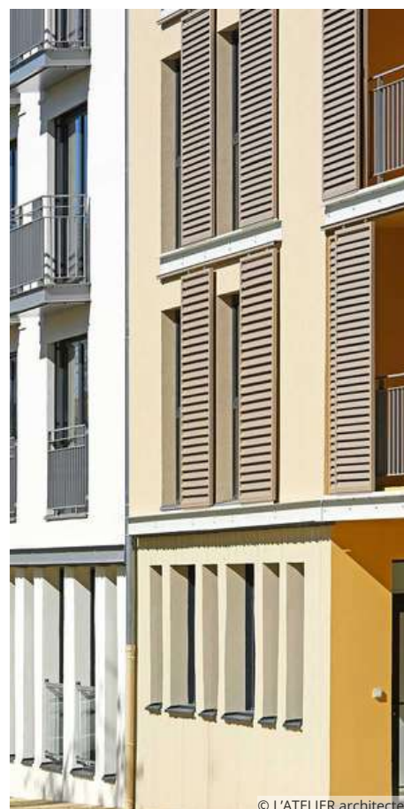
Détail du travail des façades
