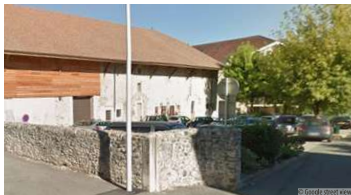
L'ancien parking venait au pied de la façade
