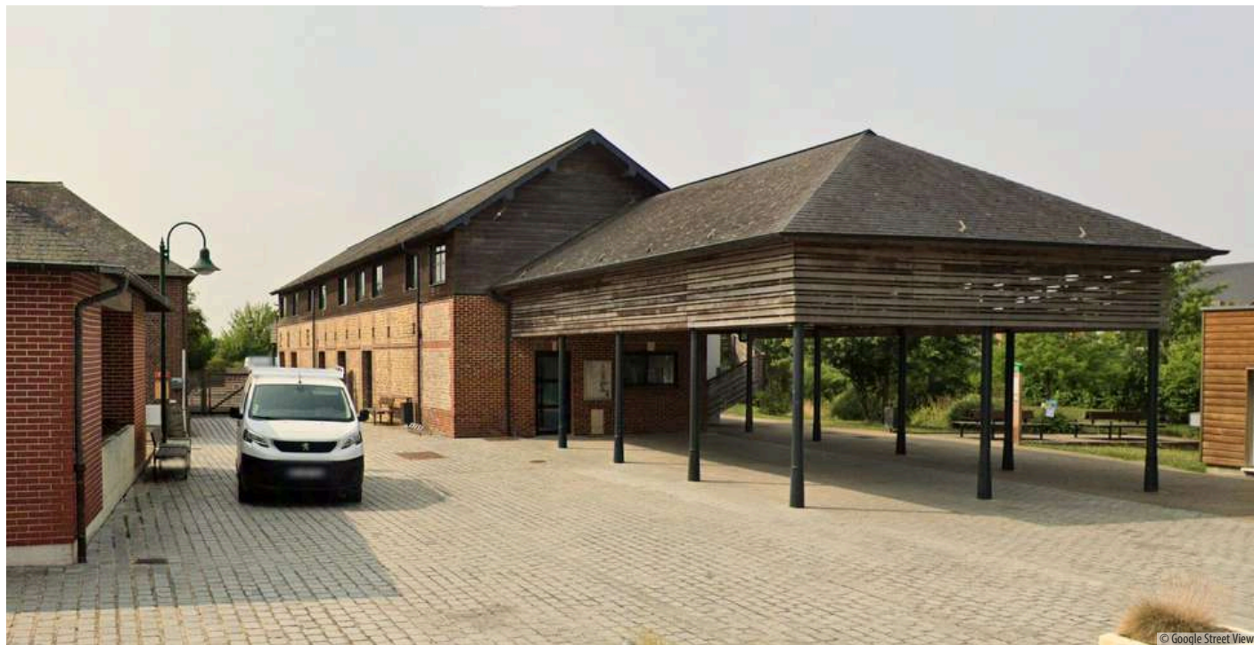
Autour de la grange réhabilitée pour des équipements communaux en rez de chaussée et des logements à l'étage, sont installées la bibliothèque, l'école et la cantine
