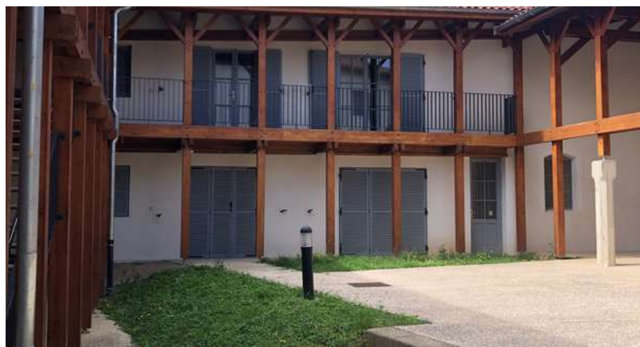
Vue sur la cour avec les coursives
