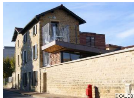
L'aspect conservé de la maison côté rue, l'extension se fait discrète
