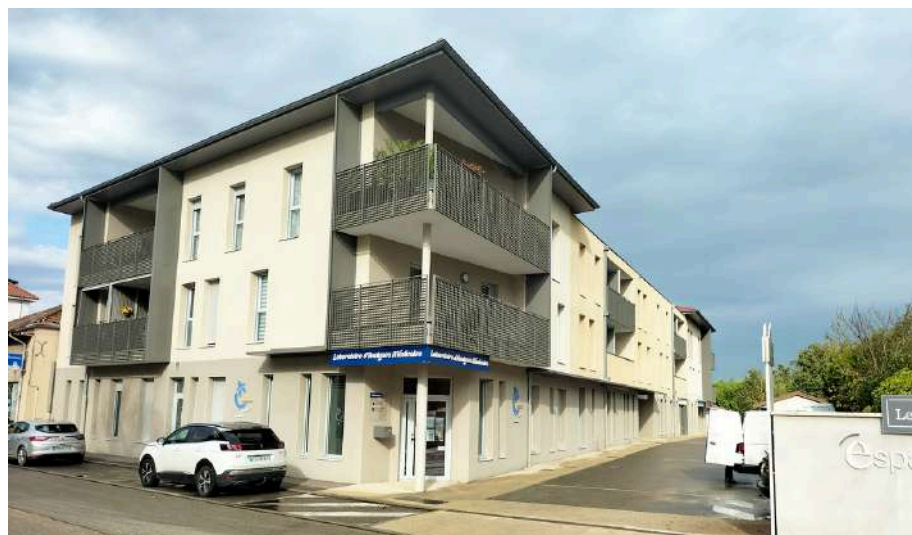
Une attention au traitement d'angle de l'opération
