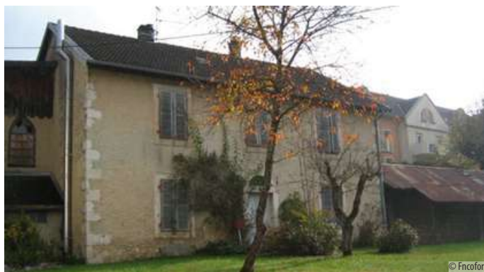
Accolée à l'église, l'ancienne cure de Confort avec sa volumétrie simple
