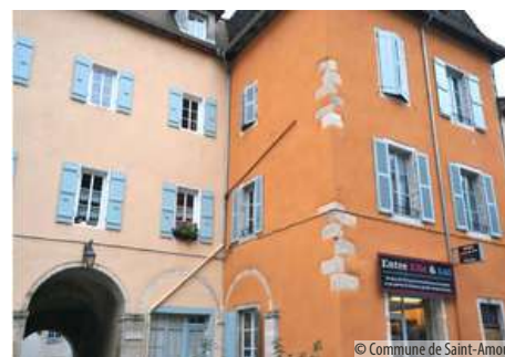
G : opération de ravalement de façades
