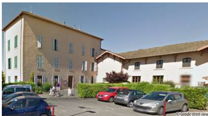
Les bâtiments avant réhabilitation
