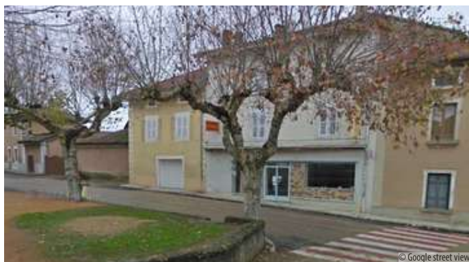
Les bâtiments démolis ont permis un nouvel alignement pour l'aménagement d'une place
