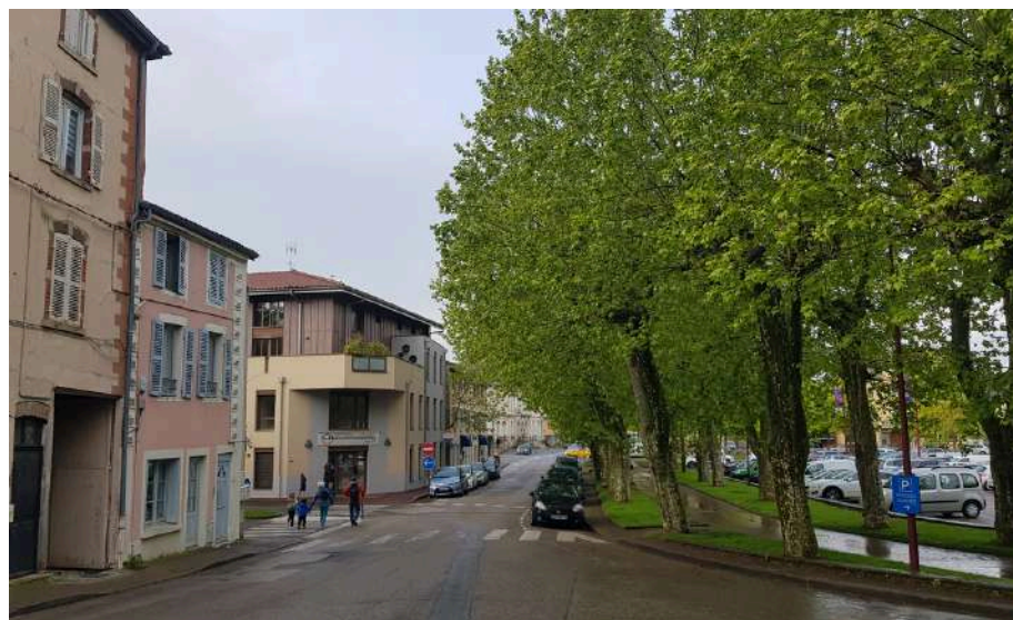
Le gabarit du bâtiment donnant sur le champ de foire s'inscrit dans l'épannelage du front bâti encadrant la place
