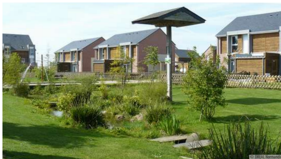
Le nouveau quartier a bénéficié de la restauration d'une zone humide pour le traitement des eaux pluviales
