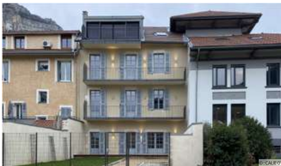
La façade arrière de la maison Magnard devenant façade principale avec ses balcons et ses ouvertures donnant sur le lac
