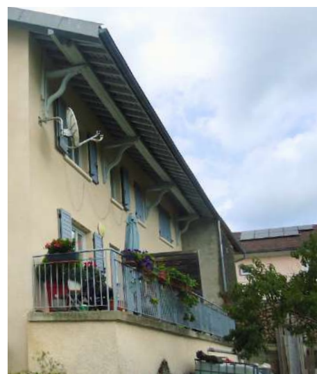
Des terrasses bien protégées par les avancées de toitures
