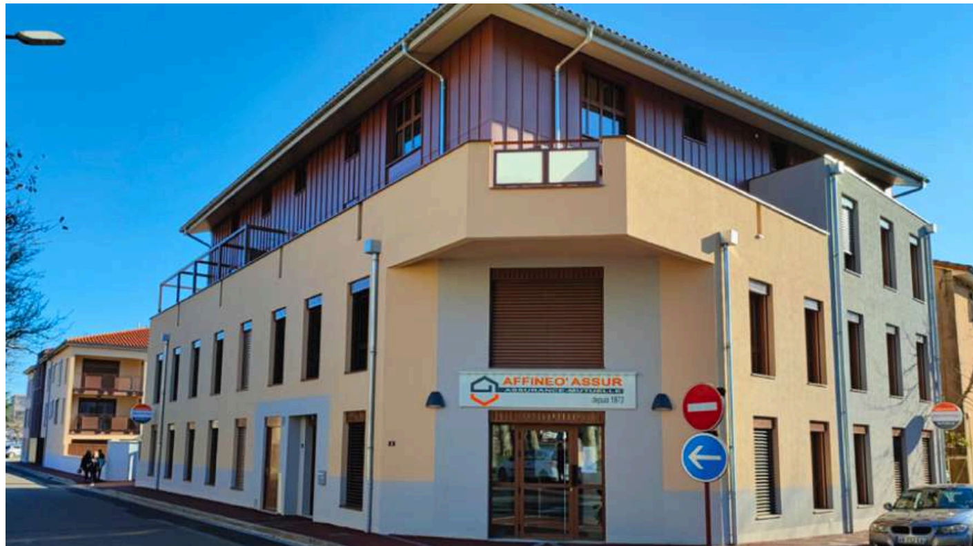
Les teintes développées en façade (deux teintes d'enduits et zinc prépatiné brun) rappellent les couleurs présentes dans le centre-ville
