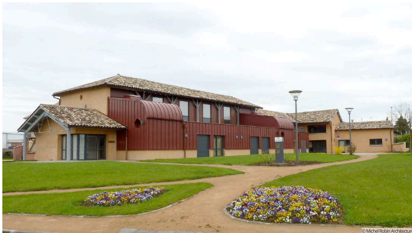
La volumétrie générale, les pentes de toit, la galerie à l'étage ont été conservées mais une extension au rez de chaussée a été créée
