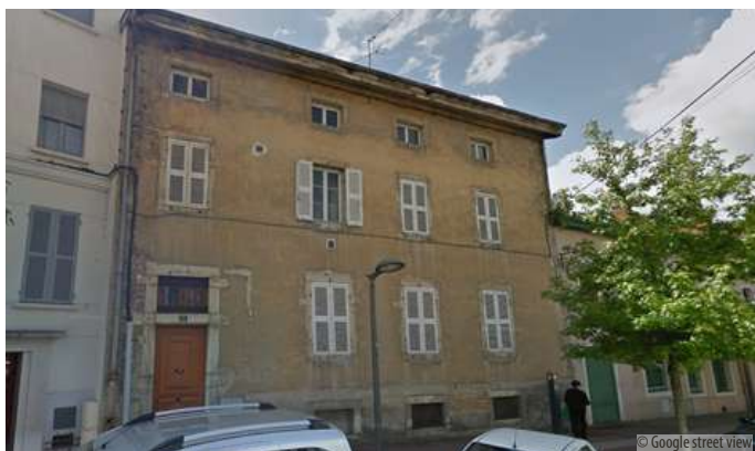
L'ancien bâtiment à la trame de façade classique
