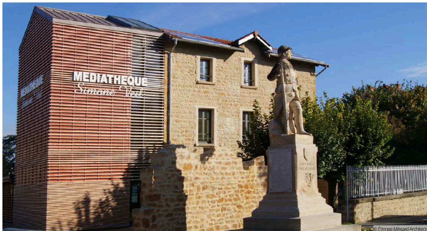
Mixité des matériaux valorisant le bâti ancien et l'architecture contemporaine
