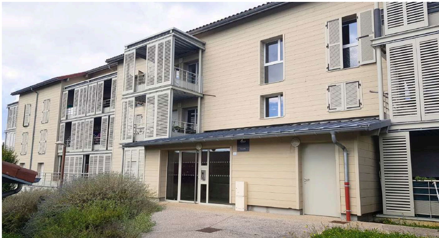
Une façade sud animée, offrant aux logements des balcons ou des loggias
