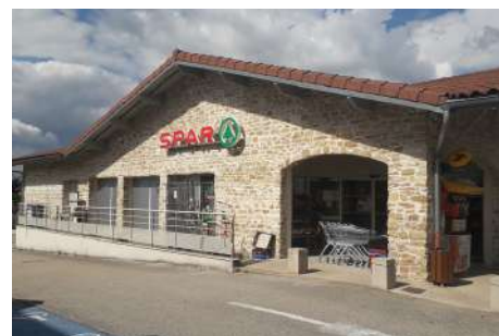
Les pierres de la grange démolie ont été réutilisées en parement
