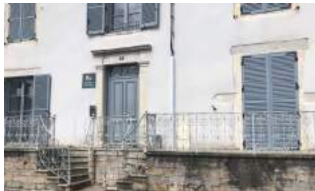
Les ferronneries restaurées
