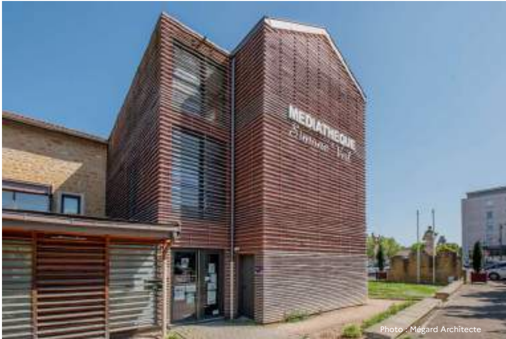
Le bâtiment vertical habillé de clins en sapin douglas
