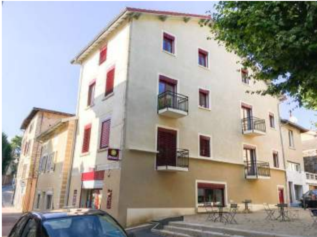
11 ouvertures créées sur l'ancien pignon aveugle
