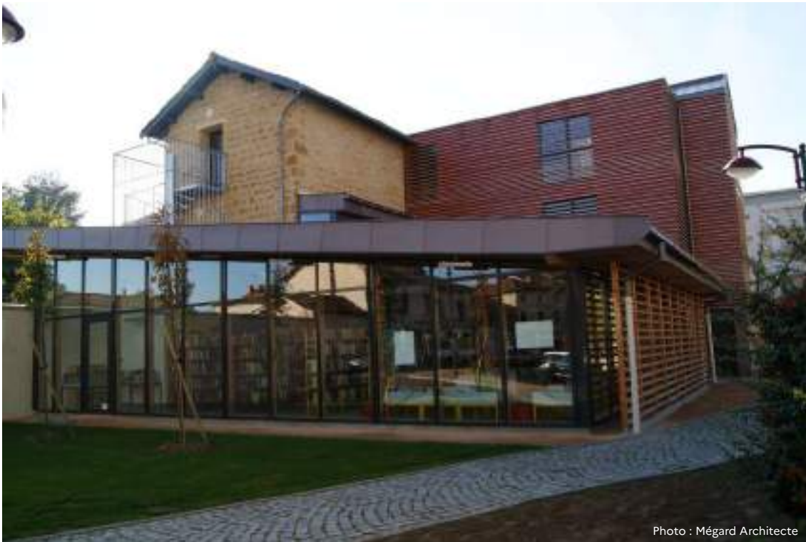
La salle de lecture neuve, devant la maison réhabilitée
