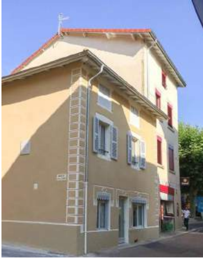
Derrière les façades sur rue réhabilitées, les deux bâtiments ont été reliés
